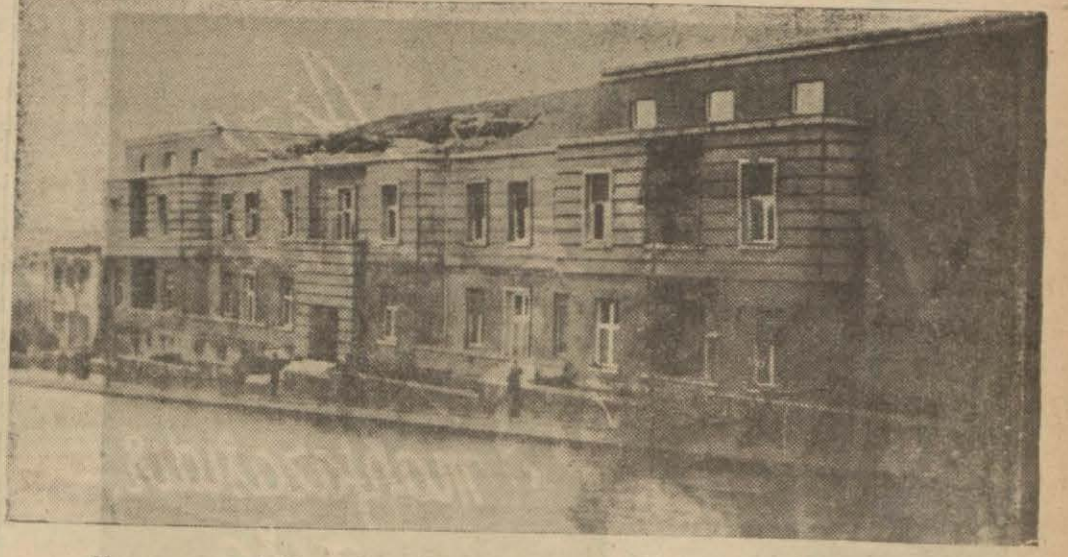
Kasırmanın tahribatından: Divanı Muhasebet binasının çöken çatısı
